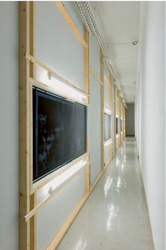
Abb. 12 Blick hinter die 26 m lange Wand, die im Ausstellungsraum errichtet wurde, um die Radiografien von hinten zu beleuchten
